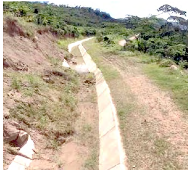
Canal de irrigación Ponaza, ha colapsado y pone en peligro la campaña agrícola.
